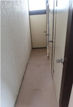
▲トイレの改修
