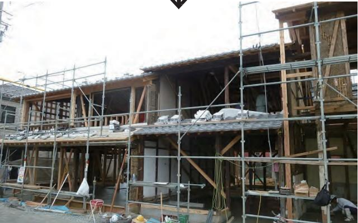
3軒一緒に改修することで1軒あたりの改修コストを抑える
